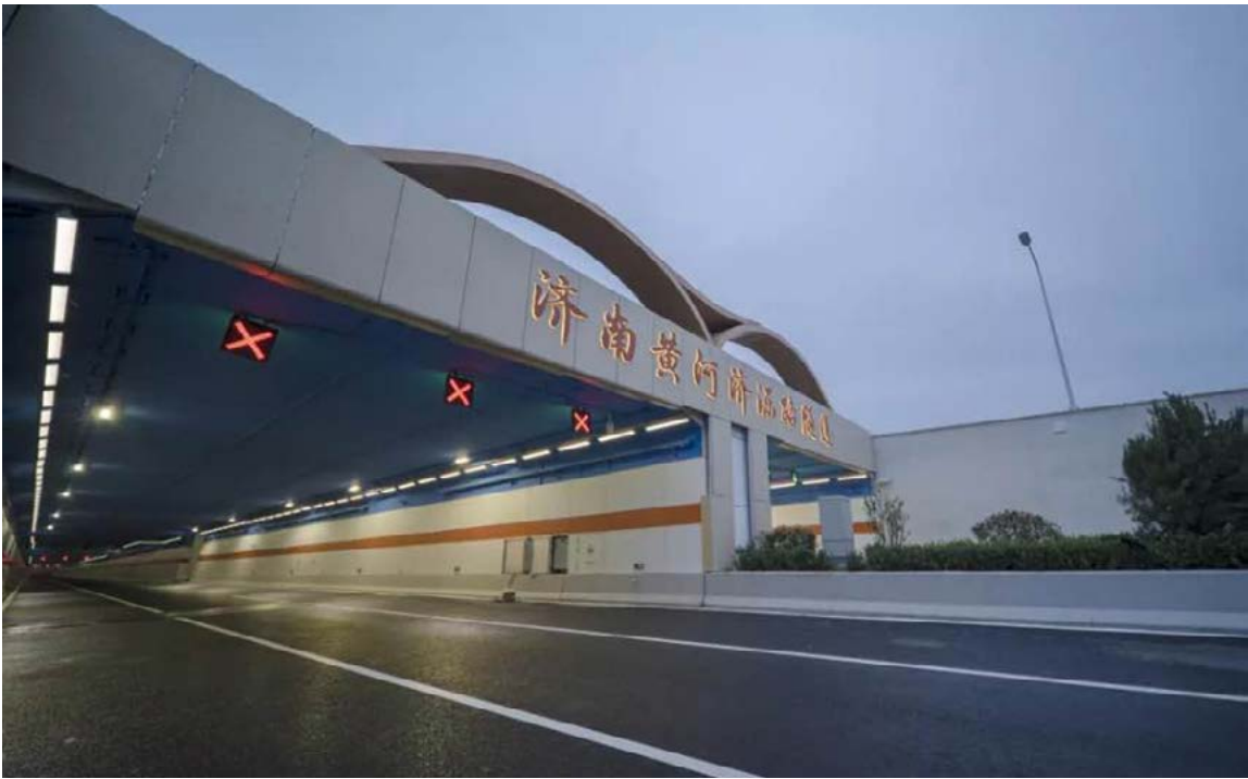
山东省分行支持的济南市隧道项目建设现场
