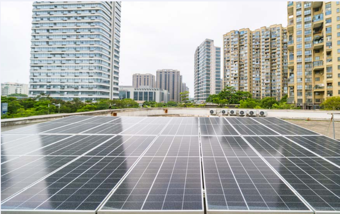
厦门政务中心支行在屋顶布设光伏设备并网发电
